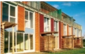
Fassadenansicht: Das Wechselspiel und die Heiterkeit der Farbgebung wurden mit Naturfarben von AURO und KEIM realisiert.
