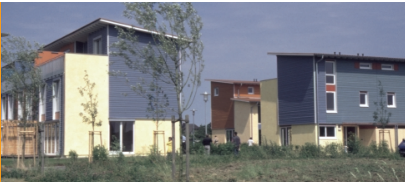
Blick auf die Siedlung von Süden.
