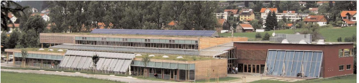
In Lindenberg im Allgäu wurde ein Wettbewerb für ein großes Werkstattgebäude ausgeschrieben, den das Architekturbüro Lichtblau aus München 2002 gewann. Das Konzept überzeugte durch die Integration von produktionstechnischen Abläufen mit einem solargestützten Energiekonzept. Um die Mehrinvestitionen gegenüber den Förderinstitutionen und dem Bauherren zu rechtfertigen, wurde das Projekt bereits in der Entwurfsphase in LEGEP eingegeben und die Zusam-
