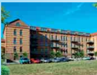
Kaserne nach dem Umbau
