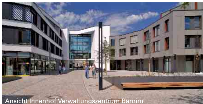
Ansicht Innenhof Verwaltungszentrum Barnim
